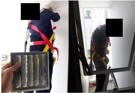
รูปที่ 2- 82 การตรวจสอบช่องระบายอากาศ
