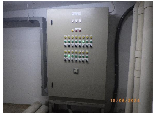
รูปที่ 2- 9 ชุดควบคุมระบบบำบัดน้ำเสีย
