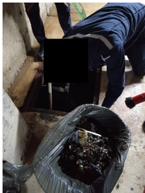
รูปที่ 2- 41 การทำความสะอาดตะแกรงบ่อดักขยะ
